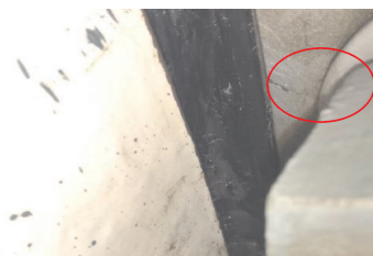
图2 变桨轴承的外圈裂纹
