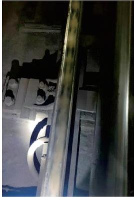
图 1 某地铁线路噪声段钢轨波磨现象
