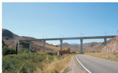
图 4 预应力混凝土连续梁桥
