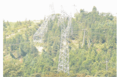
(b) 输电塔倒塌
