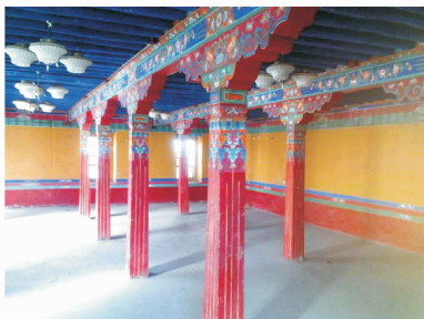
图1 典型藏式古建筑木结构
