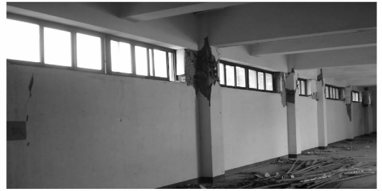
(a) C轴框架柱总体震害
