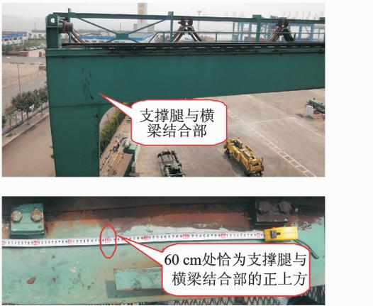
图10 场桥端部横梁检测现场
