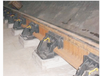
(c) 更换高弹性扣件后的轨道照片
