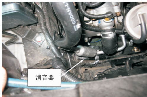
图12 空调管路消音器
