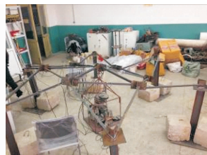
图 13 移除杆件 15 后结构破坏照片 Fig. 13 Damage picture of removing element 15
