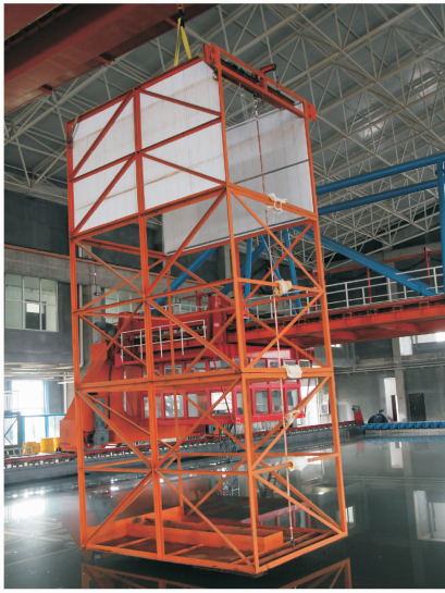
图 4 立管吊装及定位
