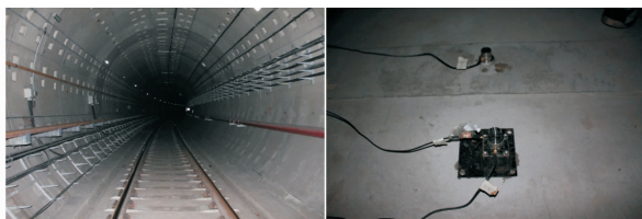
(a) 测试隧道 (a) In-situ testing tunnel (b) 测试加速度传感器 (b) Testing acceleration sensor
