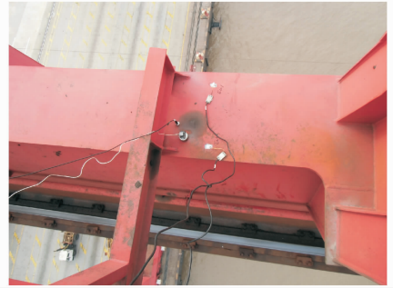
图 11 大梁跨中振动加速度测点 Fig. 11 The acceleration test point on the boom middle
