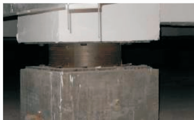
图 2 公共教学楼隔震支座节点细部
