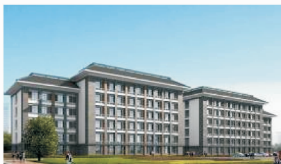
图 1 公共教学楼整体外观
