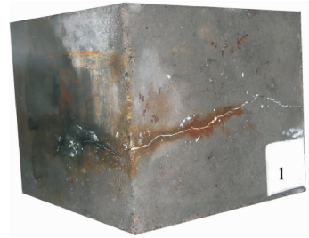
图 5 混凝土试件上的裂缝
