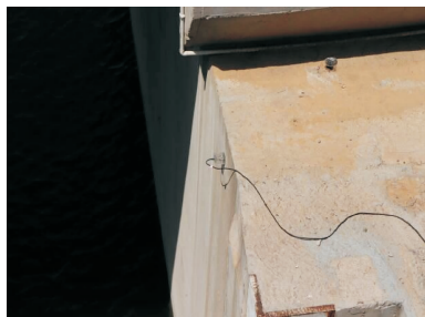
图 3 闸墩部分传感器布置
