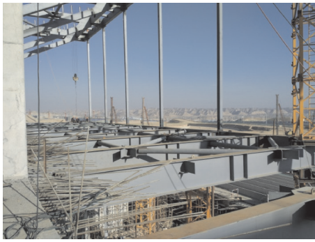
图 3 悬挑楼盖施工现场
