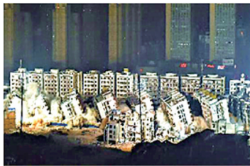
(b) 群楼坍塌
