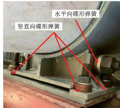
图 7 管夹现场安装图
