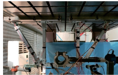
图 3 带斜撑支吊架试验安装图
