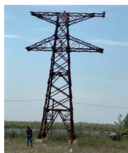
图 6 实际输电塔照片
