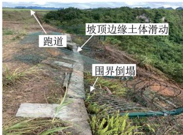
图 1 某高边坡机场坡顶土体局部滑动
