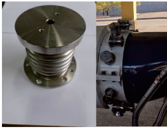
图3 吸振器在P3泵进口管道上的安装图
