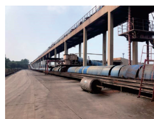
图1 栈桥整体外观
