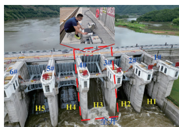
图14 溢流坝泄洪振动测试现场
